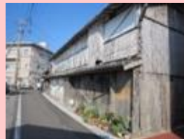
空き家の除却
