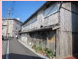
空き家の除却
