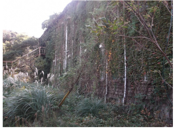
△ 第一病棟 (海軍病院時代から存置)
