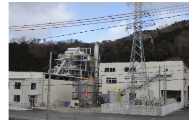
バイオマス発電所
