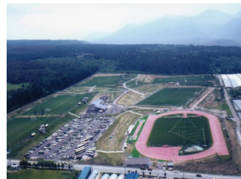
冷涼・高地の環境に充実した設備
