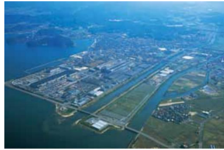
現在のプロテリアル安来工場（旧日立金属）
