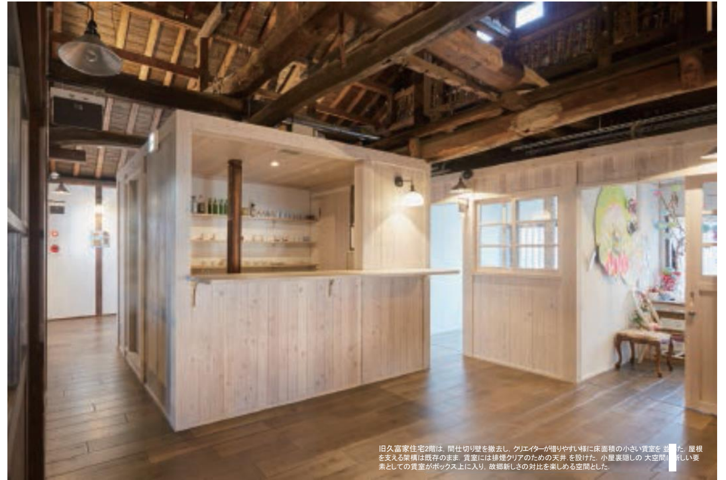
1階写真スタジオ。2階の床を剥がし吹き抜けとした。スタジオで撮影される方への配慮と空調を考慮して吹き抜け周りには壁を設けた。奥に見える梁2本は、補強材を添えてボルトで固めた。
