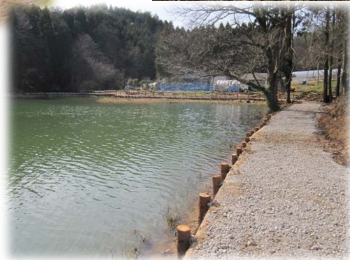
遊歩道の設置 (1.6km)
