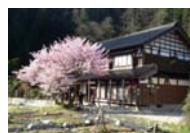
古民家等の改修
