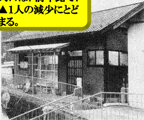
梶原町が移住者向けに改修した住宅
