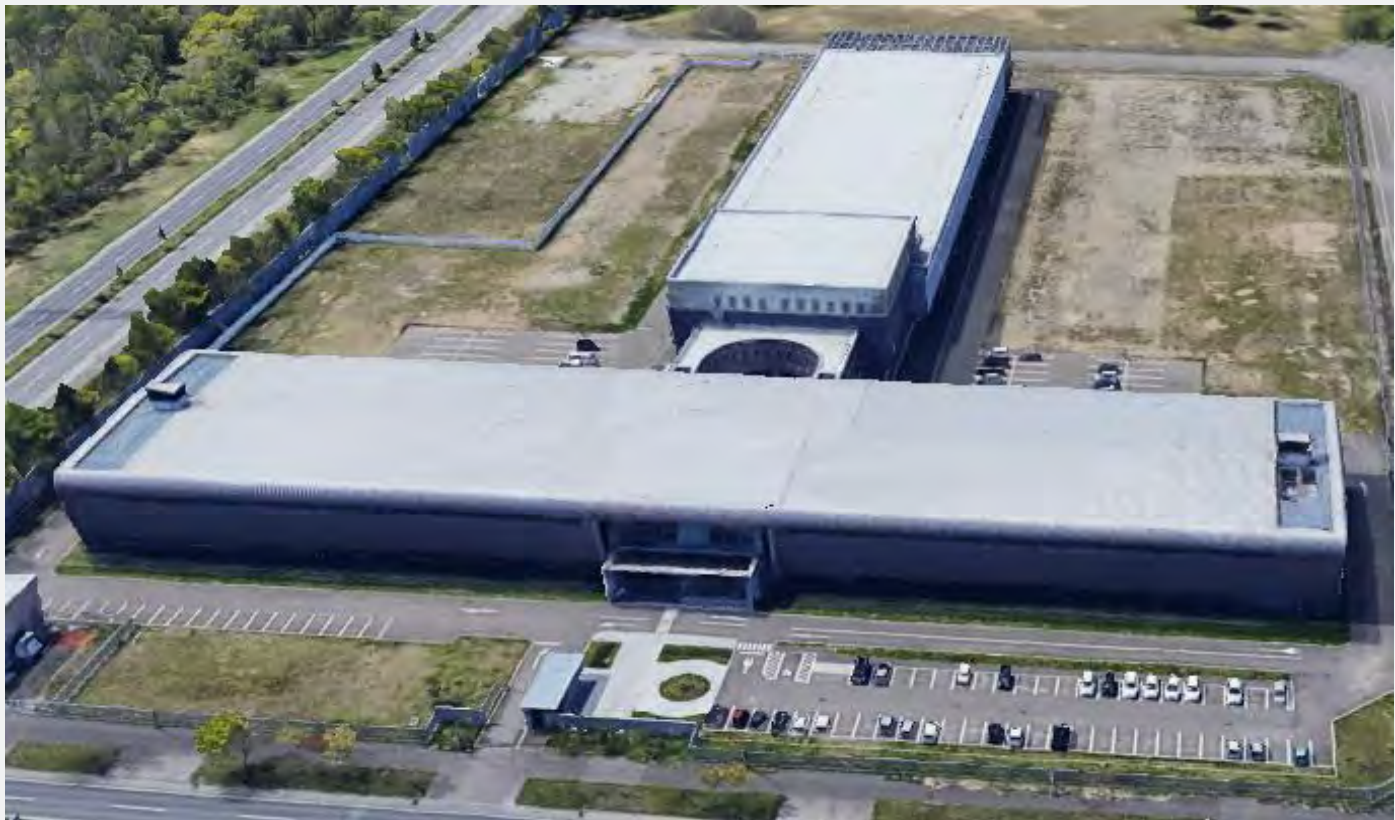
石狩データセンター 自社運営する拡張性・柔軟性・環境性に優れたデータセンター
