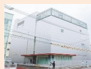
新研究棟整備
