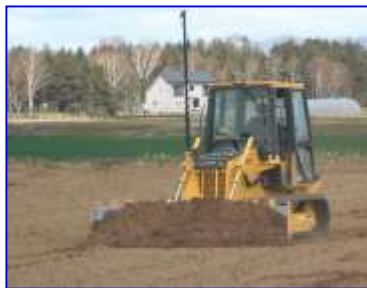
田面均平化作業 (精度±15-30mm)
