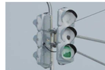
レンズについた雪が溶けず、見えにくくなった信号機
