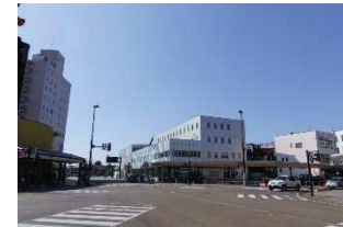
学生寮（新発田駅前複合施設）
