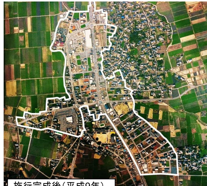
施行完成後(平成9年)
