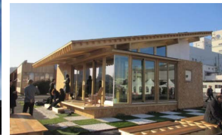
都内に建てられたCLT仮設建築物（現在は福島県に移設）
