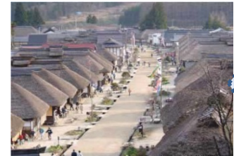
無電柱化(電柱移設)
