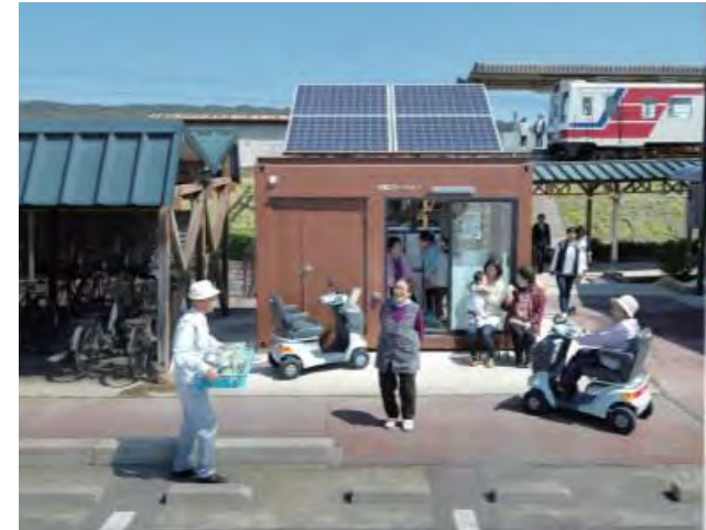
道の駅「のだ」に設置された充電ステーション。
