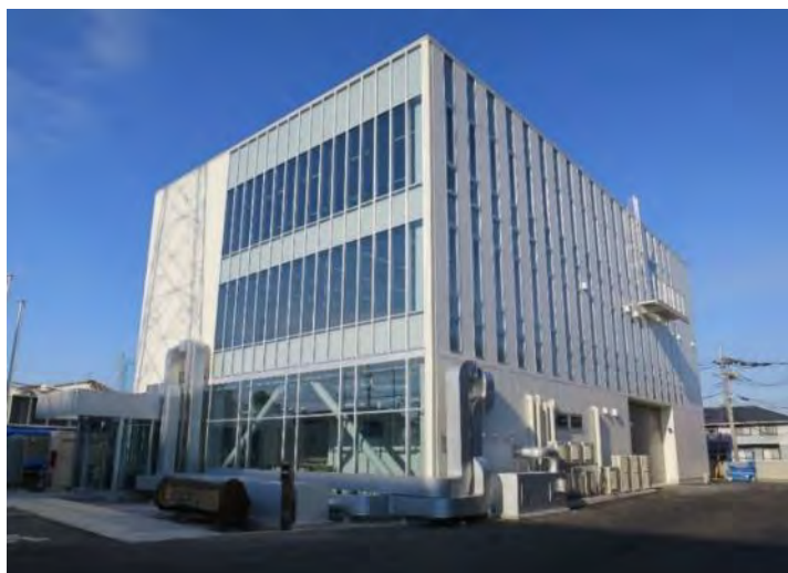
Nearly ZEBと耐震性向上を両立した白鷺電気工業新本社ビル(熊本市)
