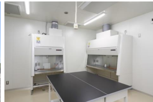
高度病原体検査室
