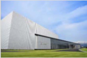
YKK AP R&Dセンター(黒部市) 【出典】同社HPより
