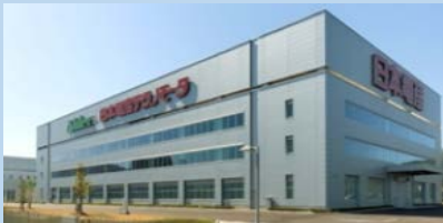
福井技術開発センター(小浜市) 【出典】同社HPより
