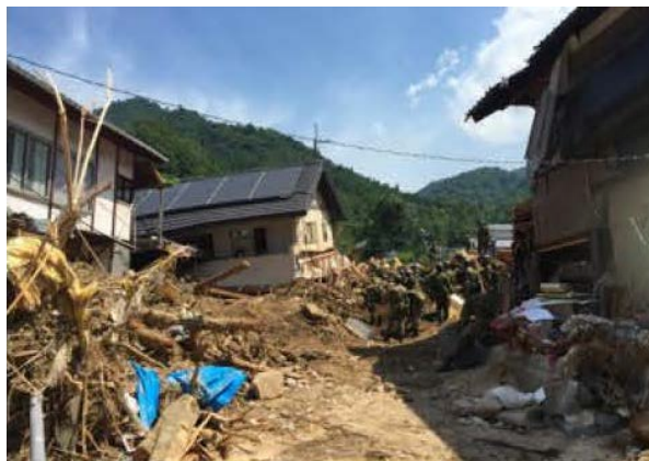
豪雨災害の被災状況(天応地区)
