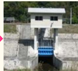
堤防整備、排水機能の強化に 併せて樋門を1箇所を集約
