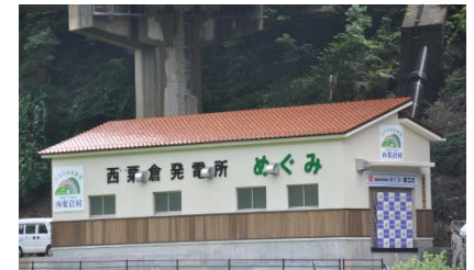
小水力発電所
