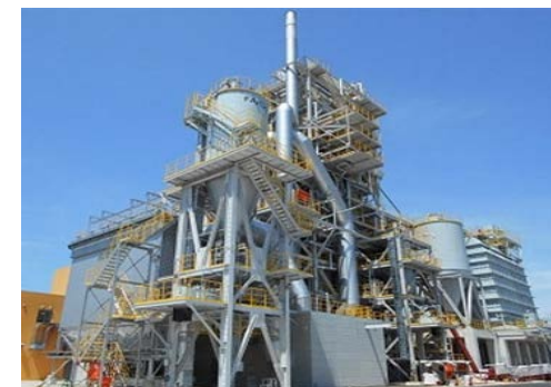
江津バイオマス発電所
