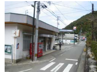
店舗・給油所の外観
