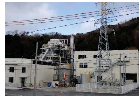
バイオマス発電所
