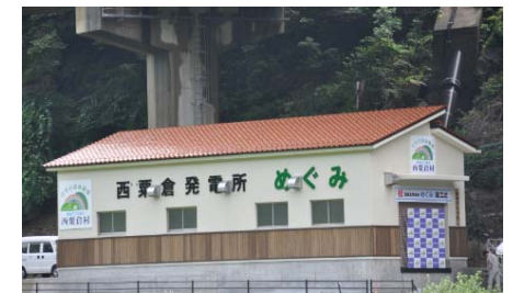
小水力発電所
