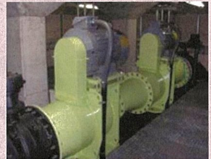
<水道施設への小水力発電の導入例>
