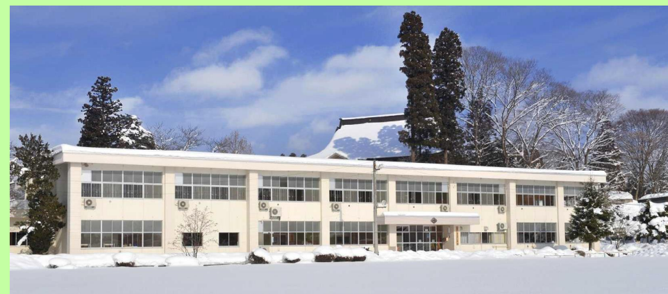
白神フーズ(株)生ハム工場 秋田県 大館市 旧山田小学校
