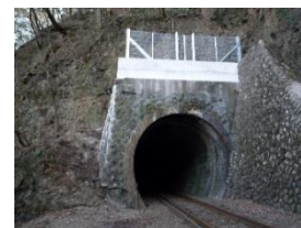
落石等防護設備
