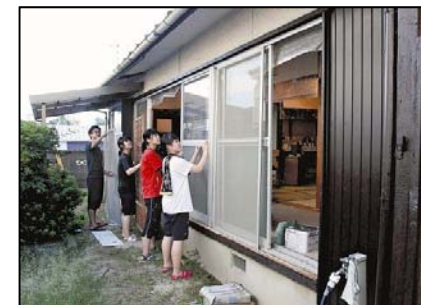
空き家の改修作業を進める香川大学の学生ら
