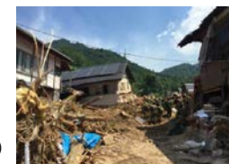
豪雨災害の被災状況(天応地区)
