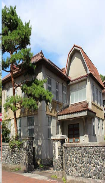
旧黒河内医院 延床面積189㎡ H29年3月開所
