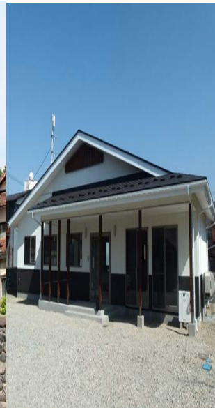
行仁町サテライトオフィス 延床面積90.46㎡ H30年3月完成
