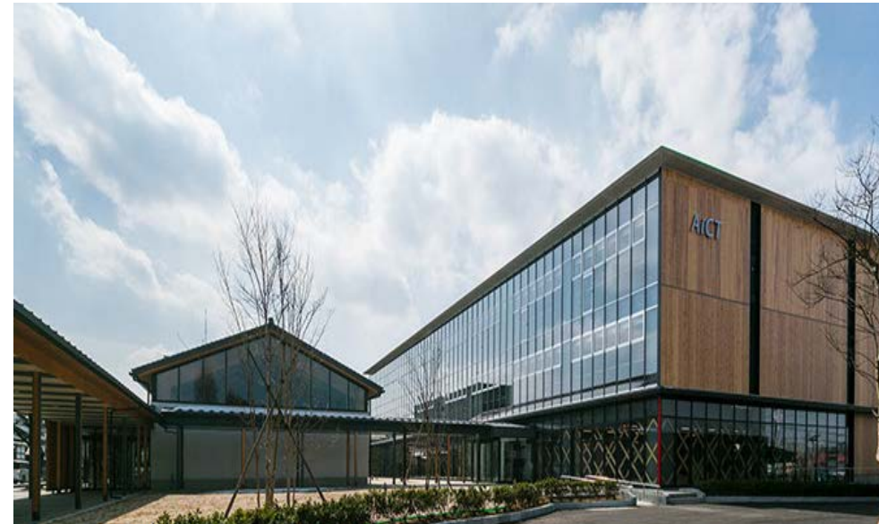
ICTオフィス『スマートシティAiCT(アイクト)』 市と民間企業が協力し、PPP／PFIにて平成31年に整備。延床面積交流棟(左)544.28㎡オフィス棟(右)1057.2㎡
