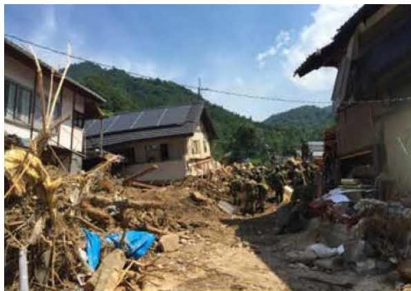
豪雨災害の被災状況(天応地区)
