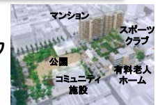
岡山市：出石小学校跡地整備事業
