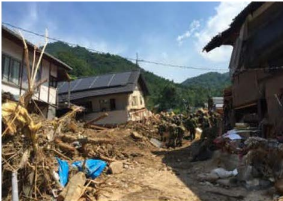
豪雨災害の被災状況(天応地区)
