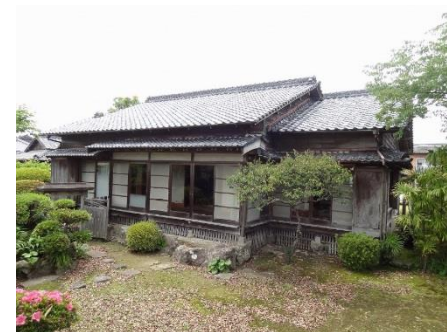
飢肥地区の古民家
