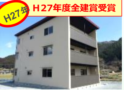
H27年 H27年度全建賞受賞 CLTの市営住宅 (H27年4月入所)
