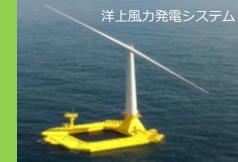
洋上風力発電システム
