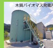
木質バイオマス発電所
