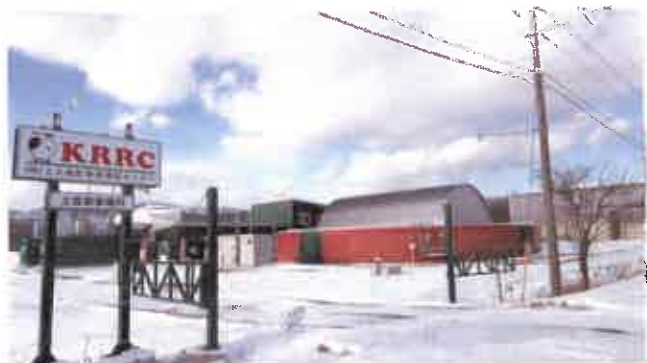
上音更地区のバイオガスプラント
