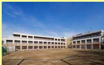
学校を改修して整備した事例
