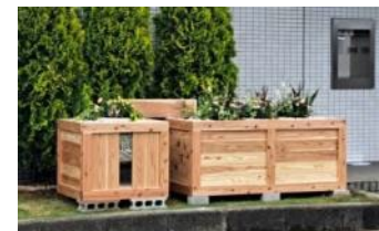
プランター型雨庭 (免田支店)
