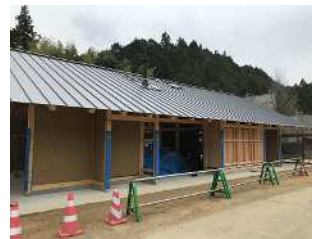
小学校跡地を活用した物販施設(五名活性化センター補完施設)を建設中
