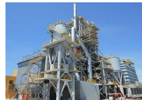
江津バイオマス発電所
