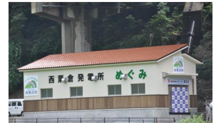
小水力発電所
