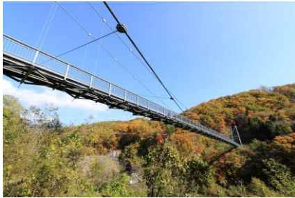
やまびこ吊り橋
