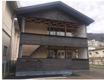
マチの棟 外観 （遊休施設となっていた 林業研修センターを改修）
