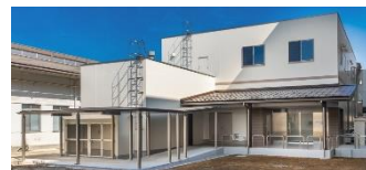
3Dデジタル生産技術共同研究棟
