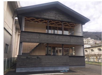
（徳島県三好市：遊休施設となっていた林業研修センターを改修（マチの棟））
