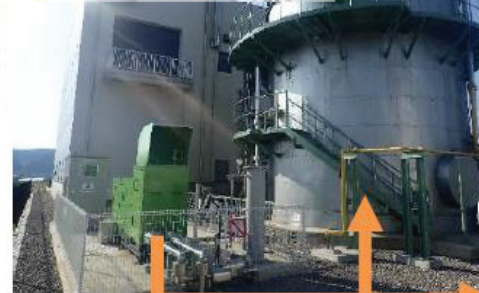
ガス発電設備の余熱はメタン発酵槽の加温や消化汚泥の乾燥に活用
