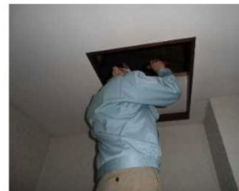
「小屋組・梁」調査の様子
