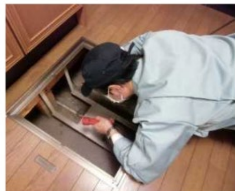
「土台・床組、基礎」調査の様子
