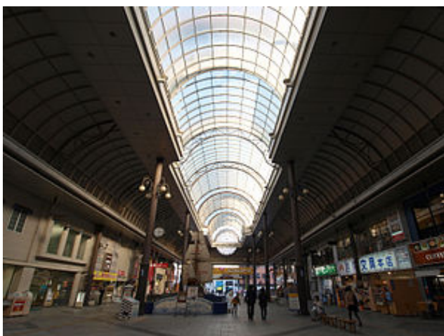
大分市(アーケード改修)
