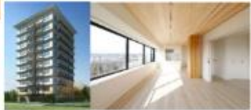
CLTを用いた10階建て共同住宅
