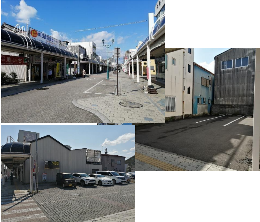
【焼津駅前通り商店街の現況】
