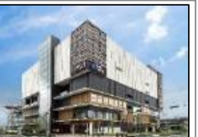
【姫路市】 『姫路キャスティ21コリアンブロック商業施設整備事業』 【テラッソ姫路】 認定: H27.6.12
