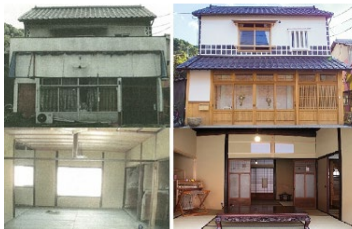
(ゲストハウス「パルビゾン」改修前・改修後)
